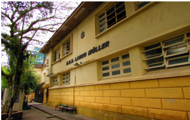
Figura 1 – Fachada parcial da escola
